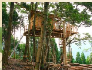
⑦階段、手摺作り
