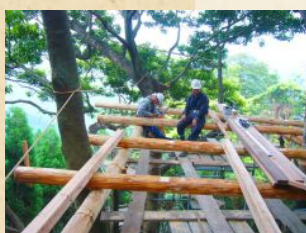
④小梁、大引組上げ
