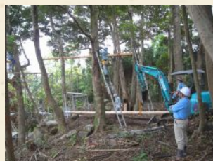
③大梁組上げ
