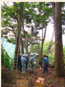
②現場整備(足場)
