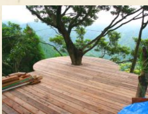
⑤デッキ張り
