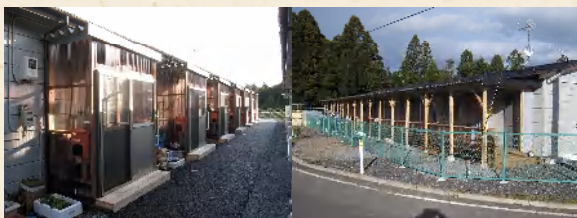
1号棟・風除室、舗装完成
