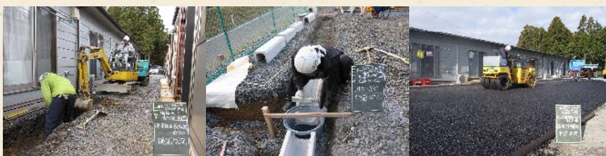
1・2号棟間掘削状況
