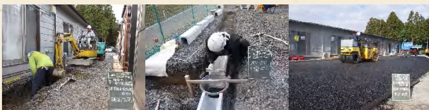
1・2号棟間掘削状況
