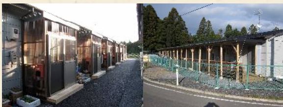
1号棟・風除室、舗装完成
